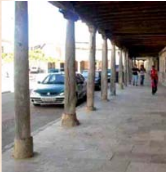
Mediante una base de piedra, se evita el contacto directo de la madera con el suelo.
