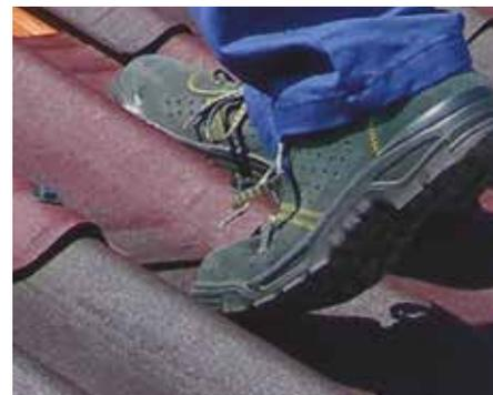
Gracias a su formato ondulado, ONDUVILLA® permite ágilmente sobre esta y sin dañar las tejas, apoyando el pie en la **parte plana** de las mismas.
