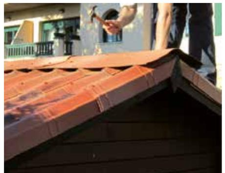
Colocar las piezas de cumbre ONDUVILLA® solapándolas un mínimo de 10 cm y fijándolas a través de la **parte alta de las ondas**.
