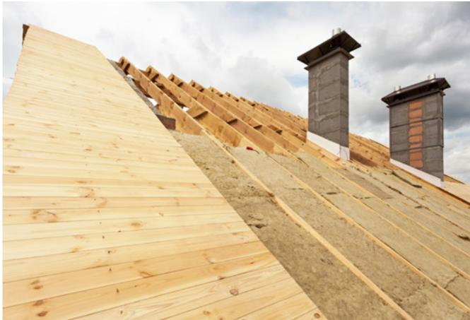
Debido a su porosidad, la madera posee una baja conductividad térmica, lo que la convierte en un excelente aislante. Combinada con otros materiales -como fibra de vidrio o lana mineral-, una construcción de madera puede satisfacer los requisitos de aislamiento térmico de una vivienda incluso en climas extremos.
